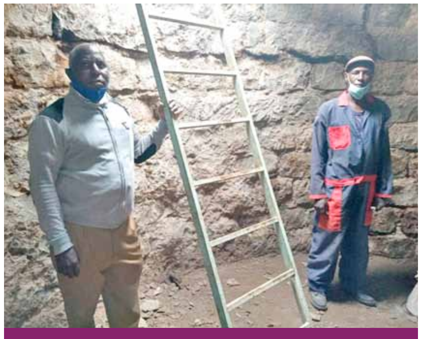
■ Die Außenhülle des Wassertanks, der für den Schulbetrieb so wichtig ist, wurde saniert.
